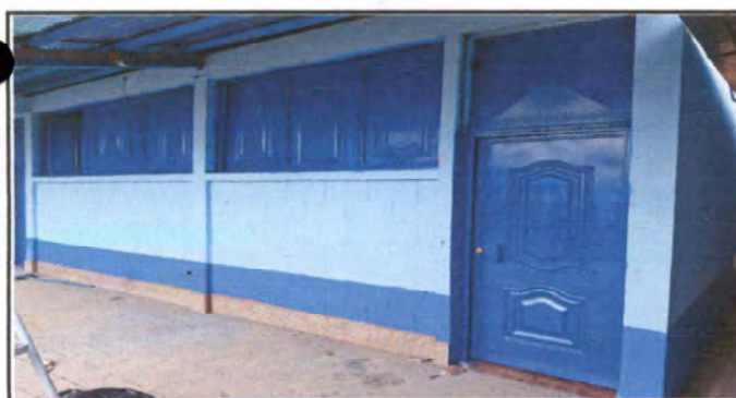
Foto 5: Sustrucción de puerta antigua por puerta nueva de paneles metalico, aula
