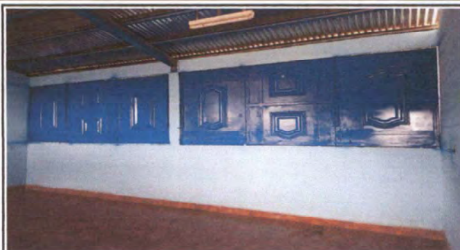
Foto 2: Sustrucción de ventana de vidrio por ventana nueva de paneles metalico
