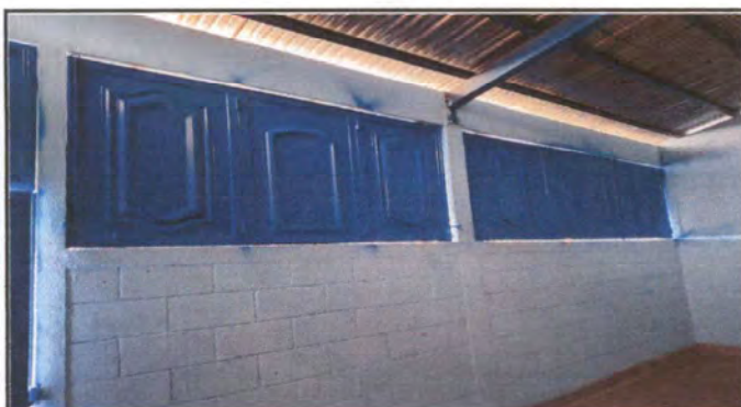
Foto 3: Sustrucción de ventana
