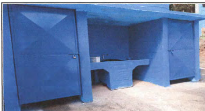
Foto 10: Reparación de puertas de baño
