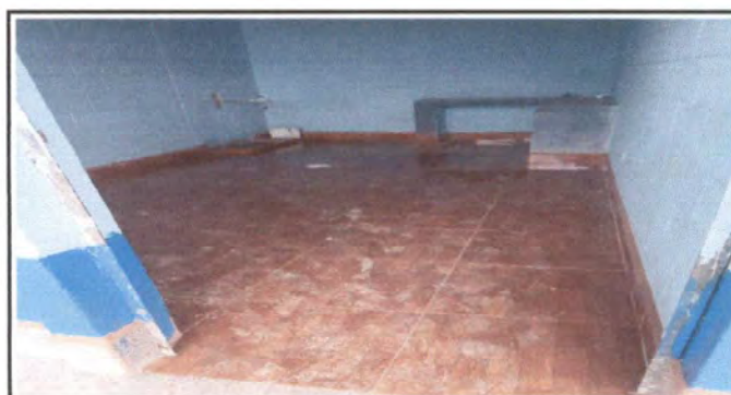
Foto 12: Instalación de piso cerámico en cocina 1
