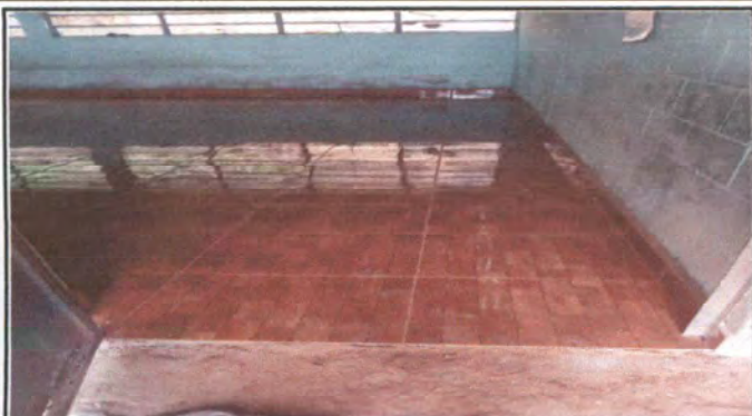
Foto 1: Sustrucción de piso concreto a piso ceramico aula
