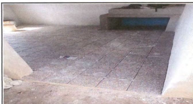
Foto 9: Instalación de piso cerámico de la cocina
