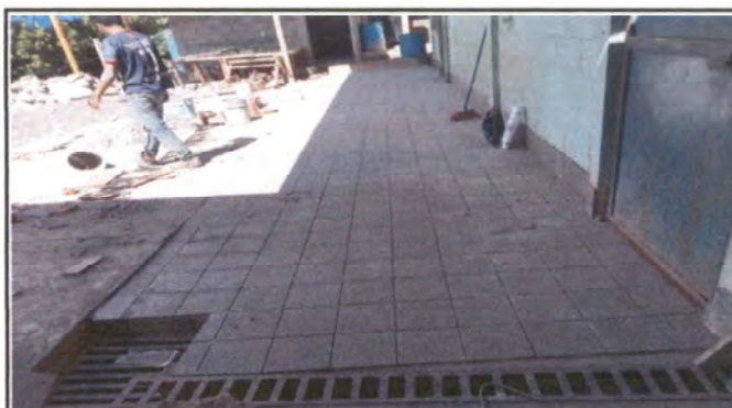
Foto 4: Sustrucción de piso de concreto e instalación de piso ceramico corredor
