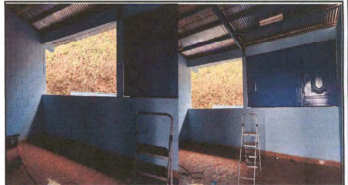
Foto 2: Sustitución de ventana de vidrio por ventana nueva de paneles
