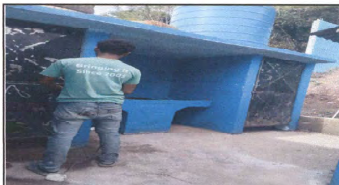
Foto 10: Reparación y aplicación de pintura de puertas de baño
