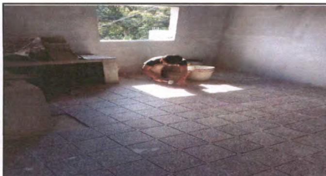
Foto 9: Instalación de piso cerámico de la cocina
