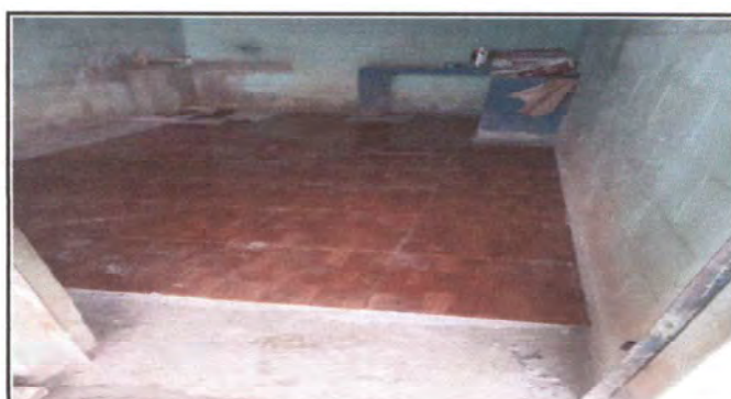
Foto 12: Instalación de piso cerámico en cocina 1
