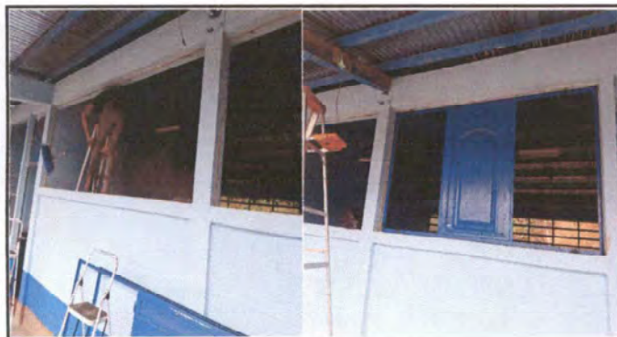
Foto 3: Sustitucion de ventana
