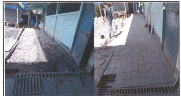
Foto 4: Sustitución de piso de concreto e instalación de piso ceramico corredor
