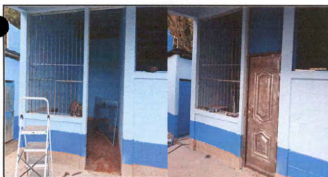
Foto 11: Sustitución de puerta antigua por puerta nueva cocina No. 1
