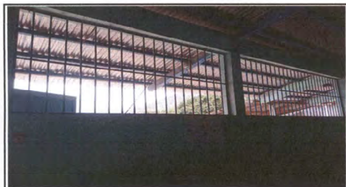
Foto 3: Sustitucion de ventana
