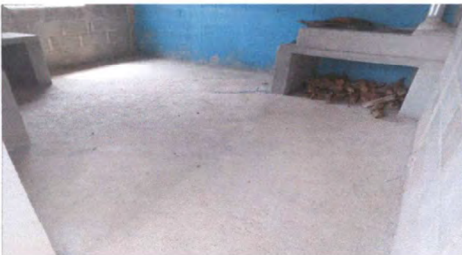
Foto 9: Instalación de piso cerámico de la cocina
