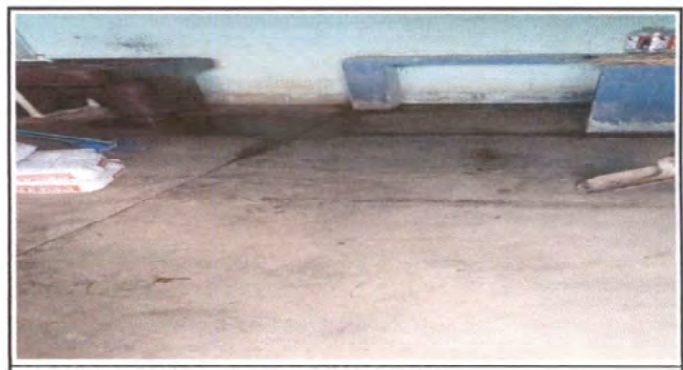
Foto 12: Instalación de piso cerámico en cocina 1
