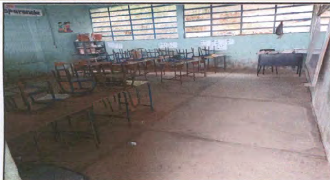
Foto1: Sustitución de piso concreto a piso ceramico aula
