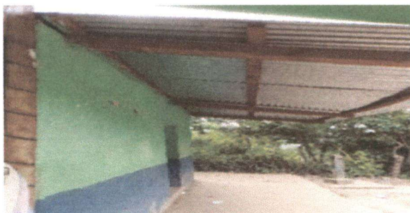
Foto 5: Sustitución de láminas, estructura de madera por metal.
