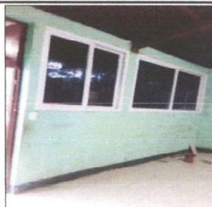
Foto 4: Sustitución de Ventanas
