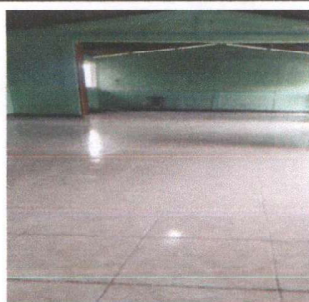
Foto 5: Sustitución de Piso
