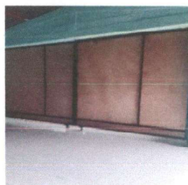
Foto 2: Sustitución de un Tabique Móvil
