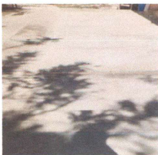
Foto 3: Sustitución Patio de losa
