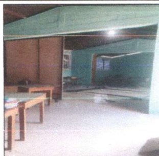
Foto 2: Sustitucion de un Tabique Movil
