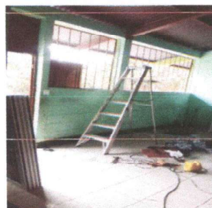
Foto 4: Sustitucion de Ventanas
