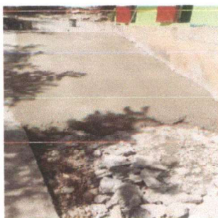
Foto 3: Sustitucion Patio de losa
