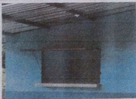
Foto 3: Sustrucción de ventanas
