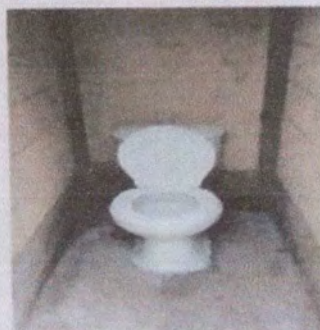
Foto 6: Sustrucción de tres baños
