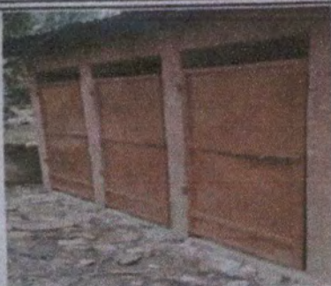
Foto 7: Mantenimiento de puertas de tres baños
