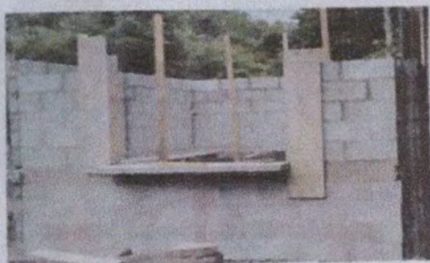
Foto 3: Sustrucción de ventanas
