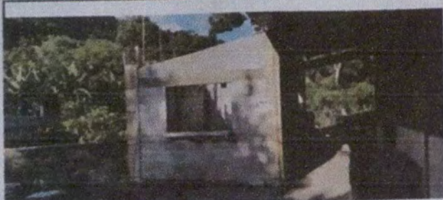
Foto 1: Sustrucción completa de paredes de cocina
