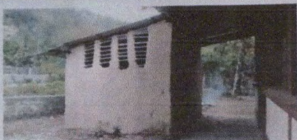
Foto 1: Sustrucción completa de paredes de cocina
