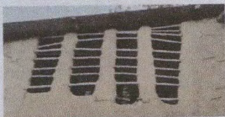
Foto 3: Sustrucción de ventanas
