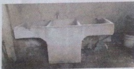
Foto 5: Sustrucción de pila
