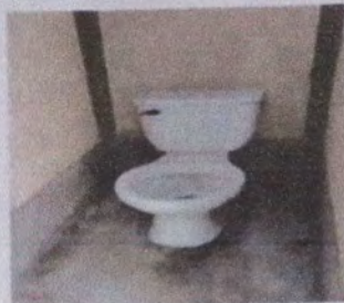
Foto 2: Sustrucción de tres baños
