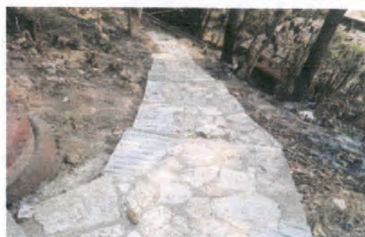
Foto 8: Reparación Rampa de Acceso.
