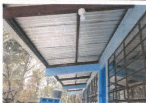
Foto 10: Reparación de Techo.
