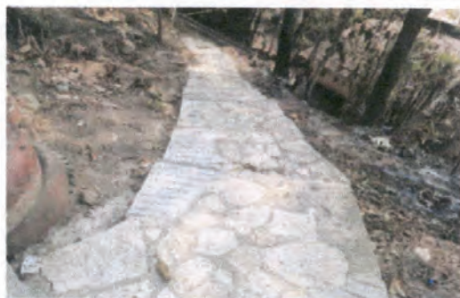
Foto 7: Reparación Rampa de Acceso.
