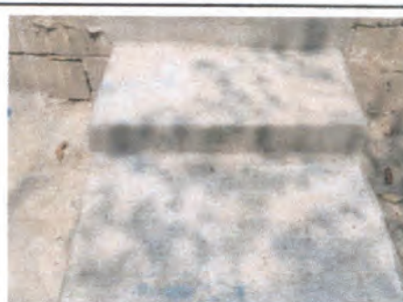
Foto 12: Reparación rampa de acceso.
