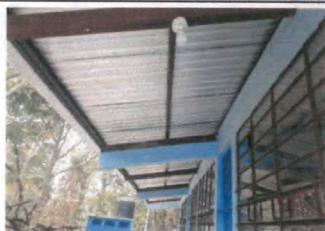
Foto 11: Reparación de cables de energía eléctrica.
