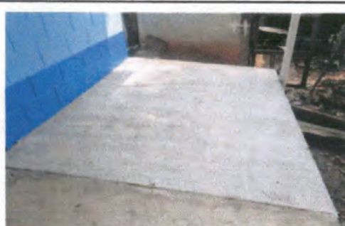
Foto 6: Reparación de Acera.
