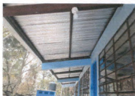
Foto 9: Reparación de Canales.
