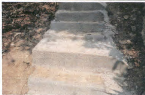
Foto 4: Reparación gradas de acceso.
