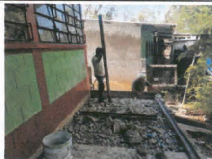
Foto 6: Reparación de Acera.
