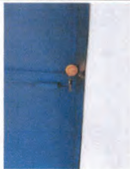
Foto 3: Cambio de Pintura de Puerta.
