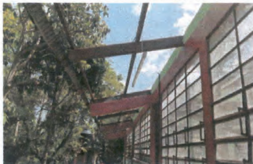
Foto 9: Reparación de Canales.
