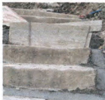
Foto 8: Reparaación Rampa de Acceso.
