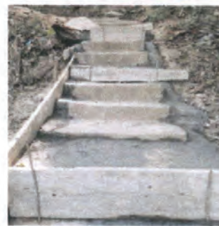
Foto 4: Reparación gradas de acceso.
