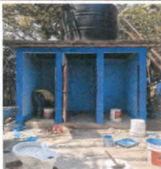
Foto 1: Reparación de Baños.
