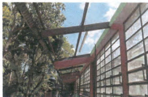
Foto 10: Reparación de Techo.
