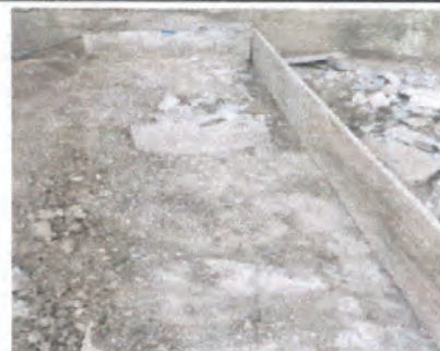
Foto 12: Reparación rampa de acceso.
