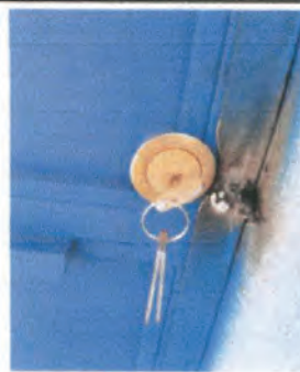
Foto 2: Reparación de Chapa de Puerta.
