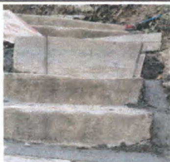
Foto 7: Reparación Rampa de Acceso.
