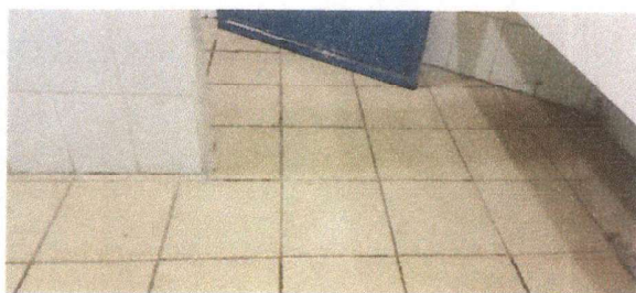
Foto 5: ya finalizado la colocación del piso
