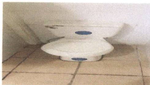
Foto 2: ya colocado el sanitario
