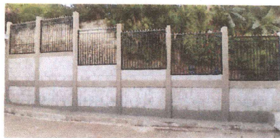
Foto 4: ya completo muro y barandales
