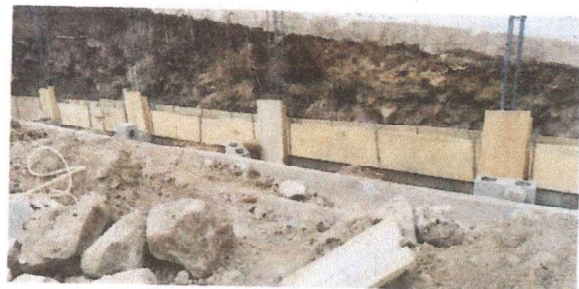
Foto 4: o Levantado de muro de block
