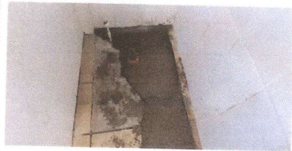
Foto 2: en proceso de echar la torta de cemento en el sanitario
