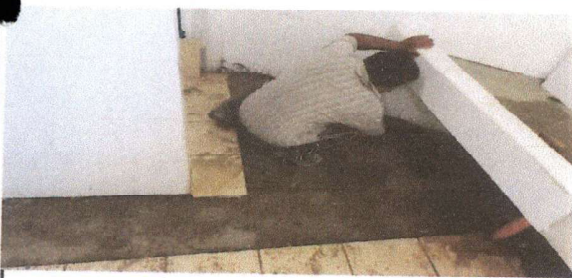
Foto 5: proceso de torta de cemento para luego colocar el piso
