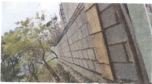
Foto 3: Levantado del muro de block
