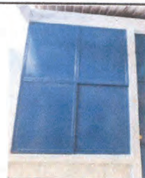
Foto 6: Reparación de ventanas.
