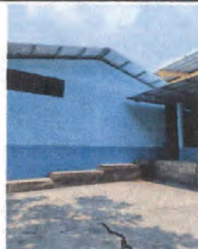
Foto 8: Cambio de pintura a paredes.
