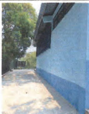
Foto 9: Cambio de pintura a paredes.
