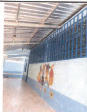
Foto 4: Colocación de balcones.
