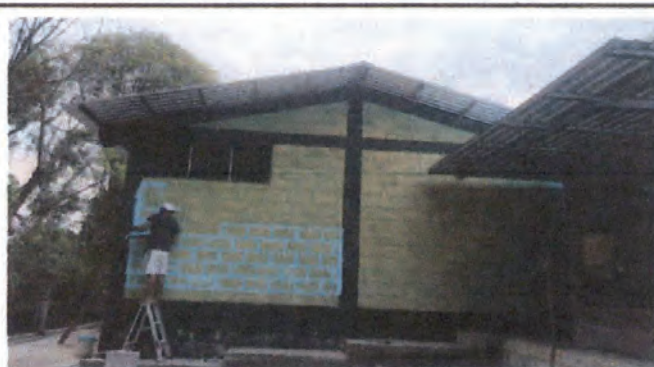
Foto 4: Pintura en paredes exteriores, 25 metros.
