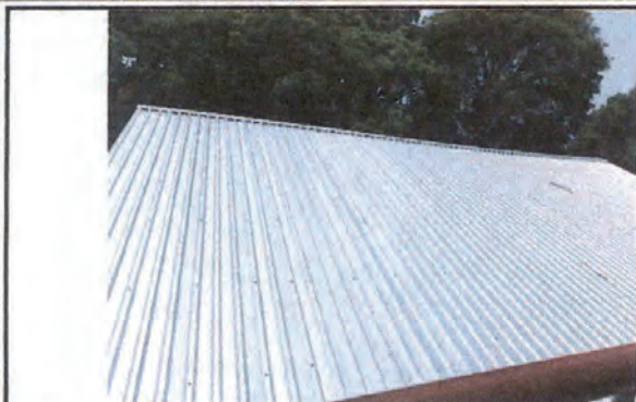
Foto 1: Instalación de techo, 184 metros.
