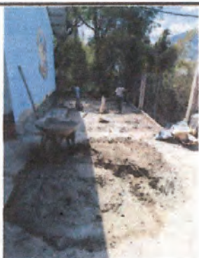
Foto 3: Sustitución de piso de torta de cemento, 20 metros.
