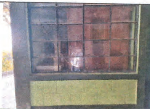
Reparación de ventana
