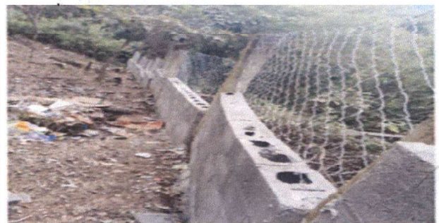
REPARACIÓN DEL MURO PERIMETRAL, PARTE DE ABAJO
