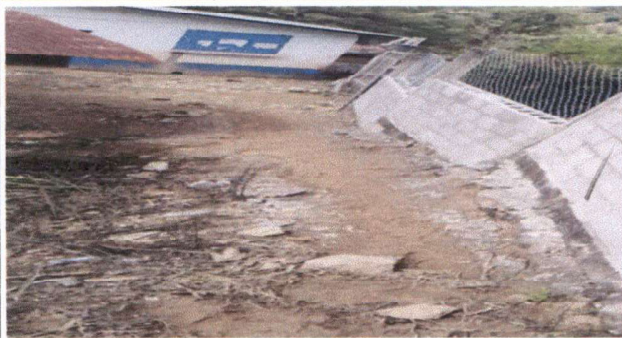
AQUÍ SE OBSERVA PARTE DE LA REPARACIÓN DEL MURO, DONDE ESTA LA ENTRADA DE LA ESCUELA
