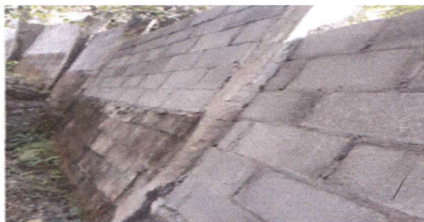
REPARACION MURO PERIMETRAL, PROBOCADA POR LAS LLUVIAS
