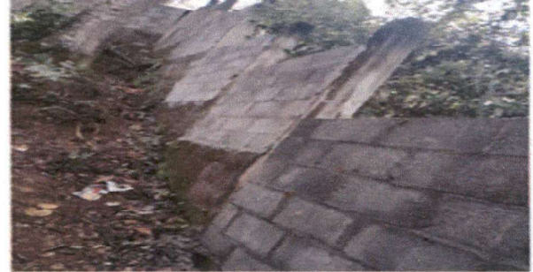
EL MURO SE ENCUENTRA REPARADO Y LEVANTADO A LA PAR DE LA CASA DE UNA VECINA, DONDE SE QUEJABA; PORQUE LA BASURA Y EL AGUA SE CORRIA PARA DONDE ELLA.
