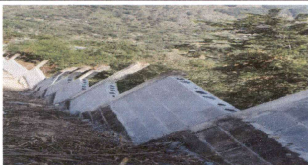
REPARACION MURO PERIMETRAL, PROBOCADA POR LAS LLUVIAS
