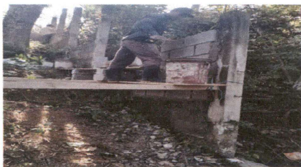
REPARACIÓN DEL MURO PERIMETRAL
