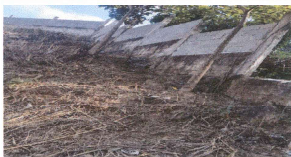
REPARACIÓN DEL MURO PERIMETRAL, PARTE DE ABAJO
