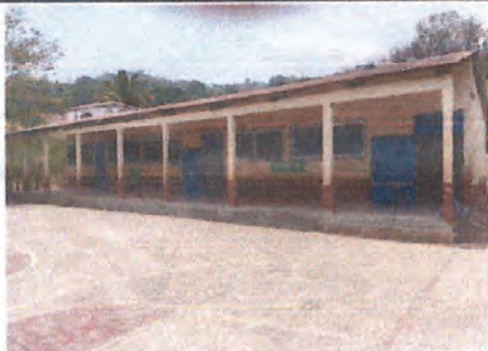
Colocación de Ventanas y balcones
