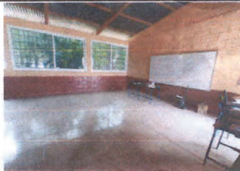
Colocación de piso cerámico en aulas.
