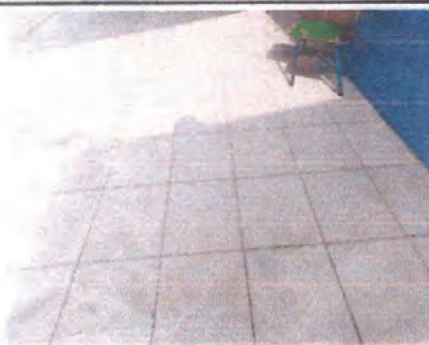
Colocación de piso cerámico
