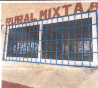
Aplicación de pintura de balcones
