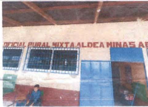
Cambio de barillas de acero a balcones
