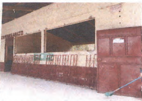
Balcones y ventanas en mantenimiento.
