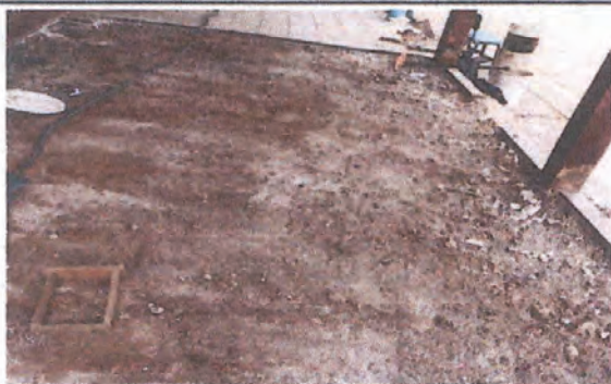
Sustitución de piso en mantenimiento.
