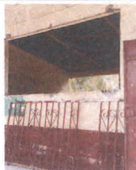
Balcones en mantenimiento.
