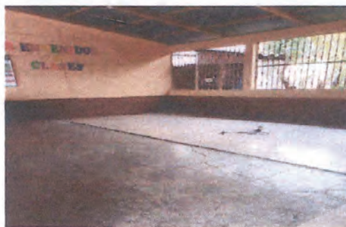
Colocación de piso cerámico.
