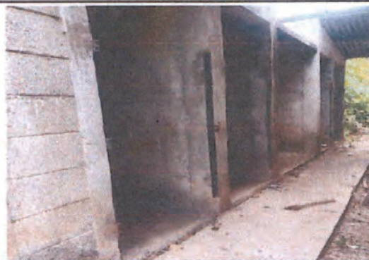
Puertas de servicios sanitarios en mantenimiento.
