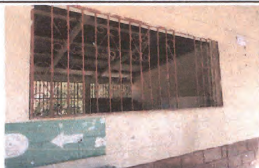
Balcones necesitan mantenimiento. Cambio de varillas de acero dañadas y aplicacion de pintura anticorrosiva
