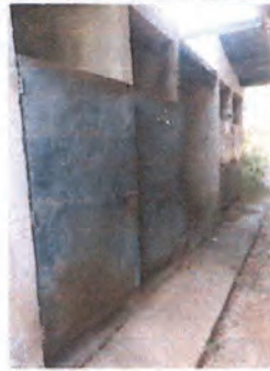
Puertas de servicios sanitarios en mal estado, lamina tiene corrosión, sobretodo en la parte inferior
