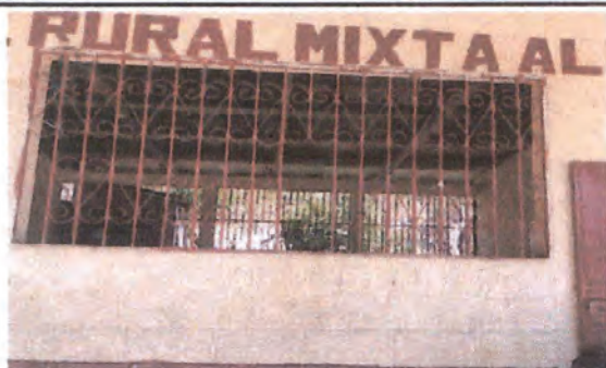
Balcones necesitan mantenimiento. Cambio de varillas de acero dañadas y aplicacion de pintura anticorrosiva
