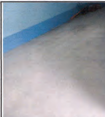
Proceso terminado de del piso de concreto
