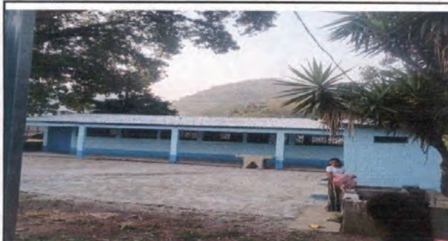
Proceso terminado de reparacion de laminas del techo en aulas nuevas
