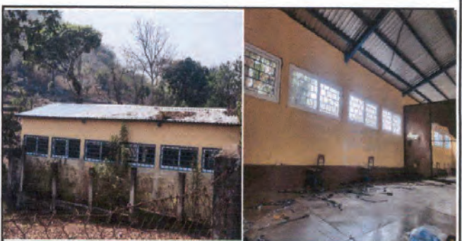
Proceso terminado de Instalacion de ventanas de PVC
