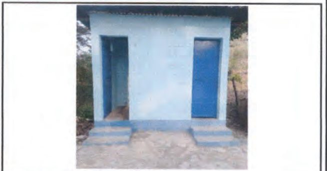
Proceso terminado de reparacion de los baños
