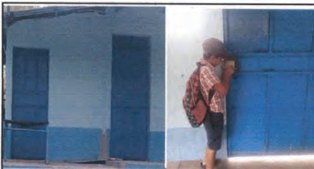
Proceso terminado de reparacion de puertas
