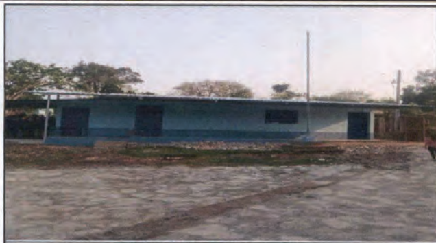
Proceso Terminado del techo en aulas antiguas
