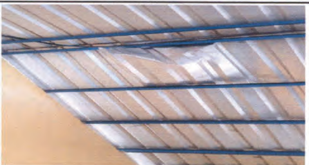
proceso de reparacion de techado en aulas nuevas
