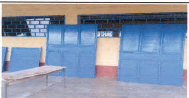
Proceso de reparacion de puertas
