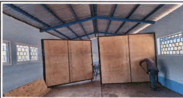
Proceso de reparacion del tabique movil
