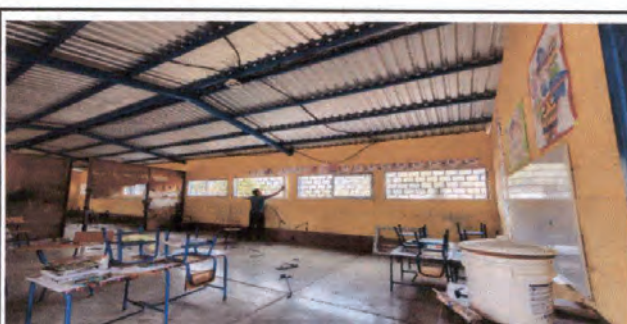
proceso de instalacion de ventanas PVC
