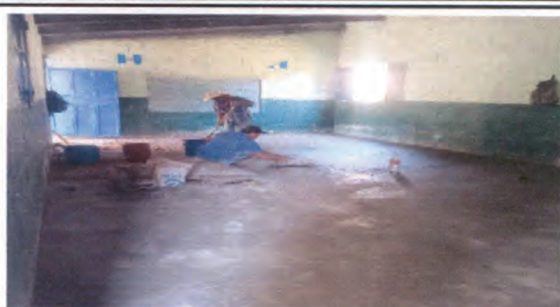
Proceso de reparación de piso de concreto en aulas
