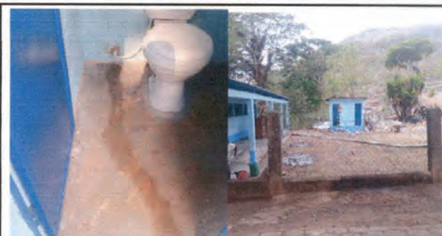
proceso de reparacion de servicios sanitarios
