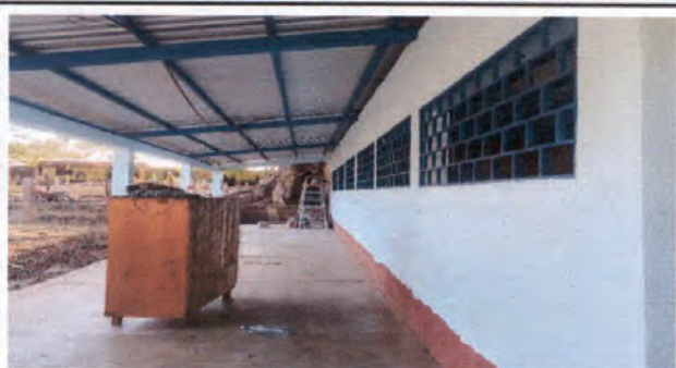
Proceso de instalación del sistema eléctrico
