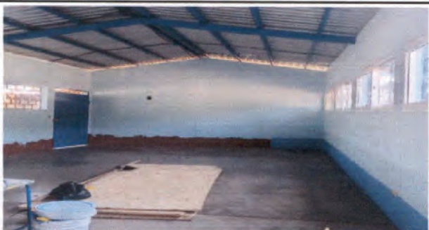
proceso de pintado en las aulas
