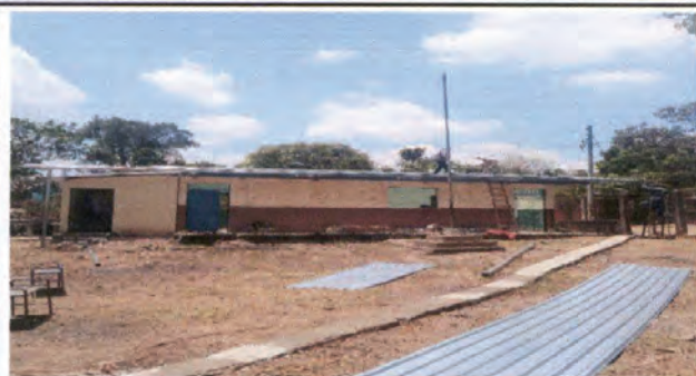
Proceso de reparacion del techado de aulas antiguas
