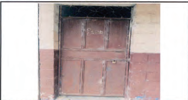
Reparación de puertas
