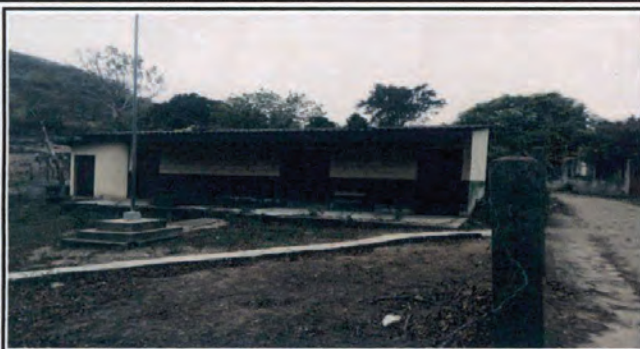
Reparación de techado de aulas antiguas (reparación de estructura y lamina g)
