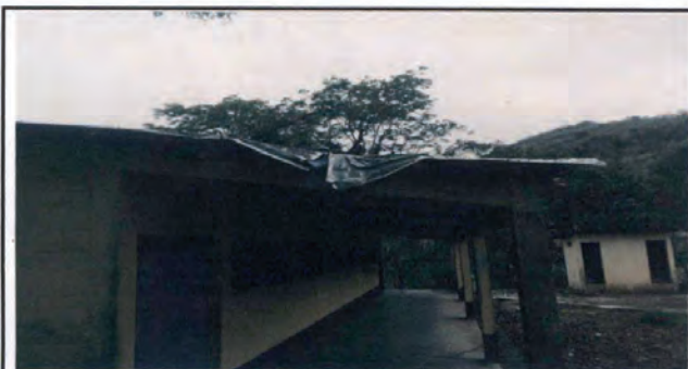
reparación de pintura
