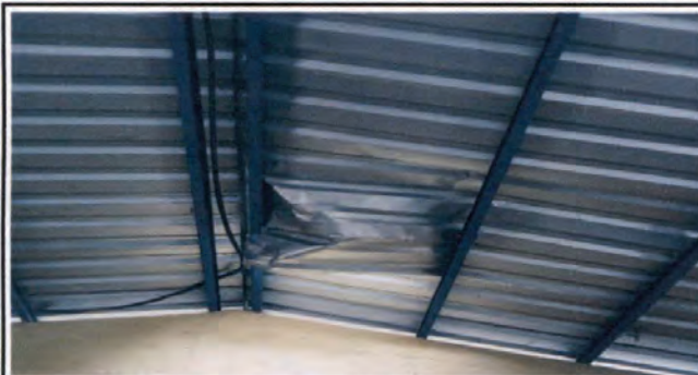
Reparación de techo en aulas nuevas
