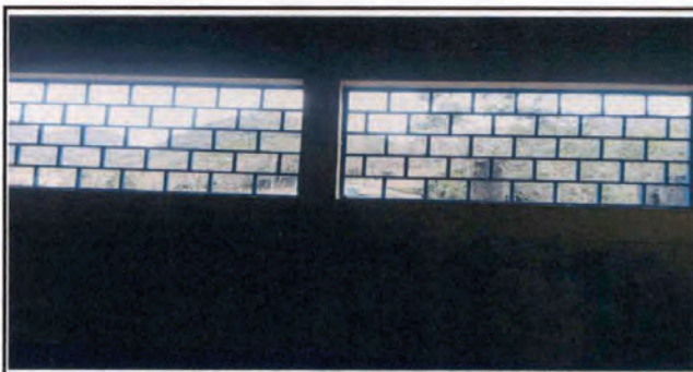
Reparación de ventanas
