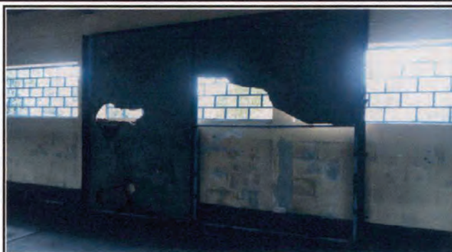
Reparación de Tabique Movil
