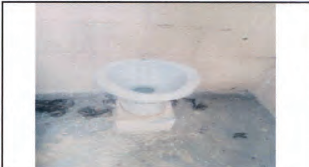
Reparación de servicios sanitarios
