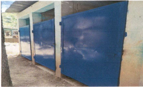
Pintado de puertas de los baños
