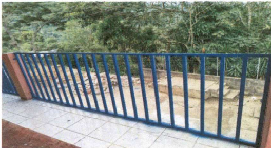
Barandales pintados y finalizados
