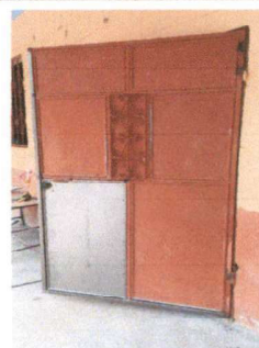
Inicio de reparacion de puerta principal
