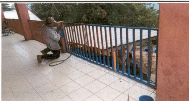
Inicio de pintura del de los barandales
