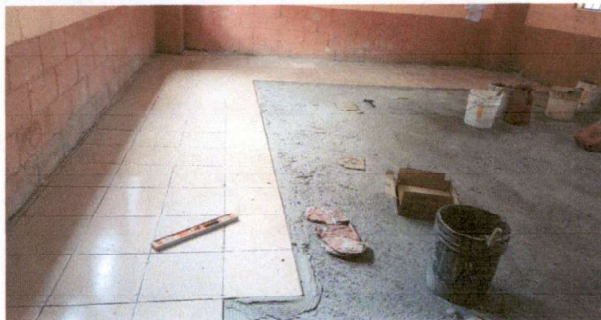
Inicio de y reparacion de piso cerámico
