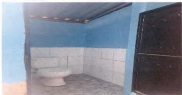
Foto 1: Los baños fueron totalmente cambiados por tazas nuevas, lavables, solo falta la pintura.
