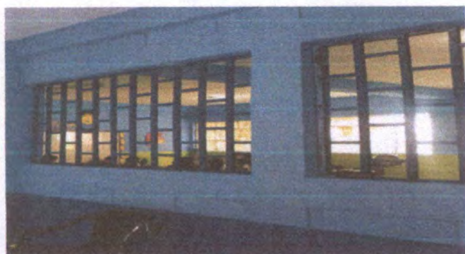
FOTO 3: Reparación de balcones metálicos
