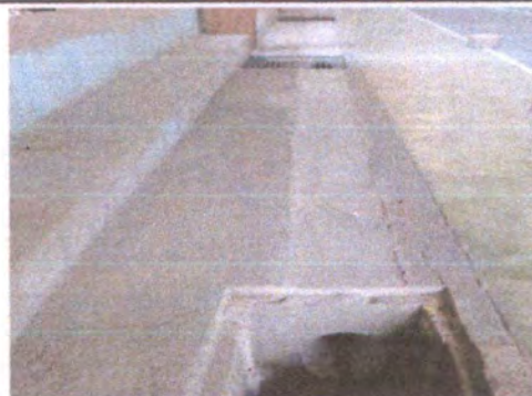
FOTO 6: Reparación de tubería de drenaje pluvial
