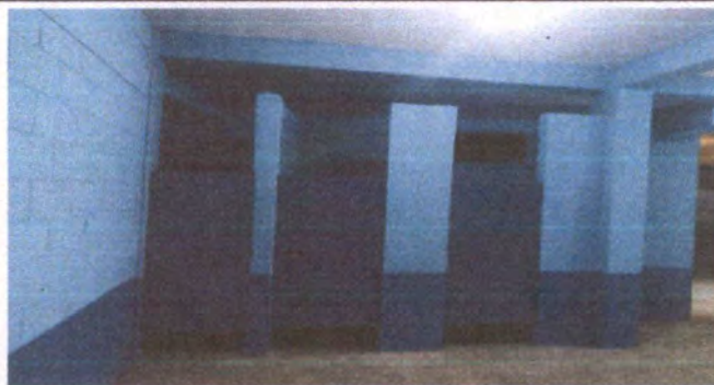
FOTO 8: Levantado de muro para area de baño
