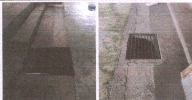
FOTO 5: Reparaciones en cajas de drenaje pluvial
