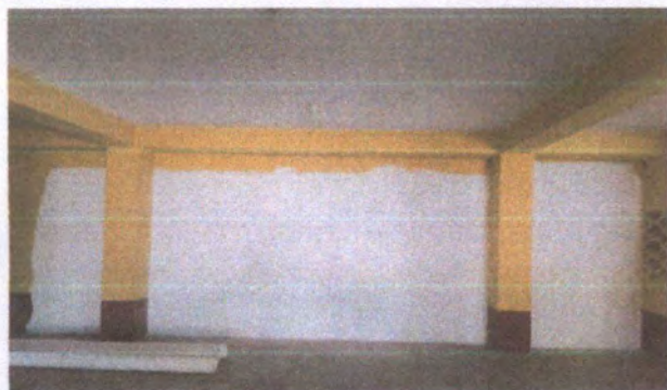
FOTO 7: Remozamiento de repello en muro
