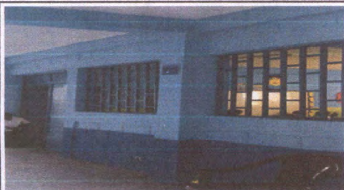
FOTO 9: Aplicación de pintura en muros
