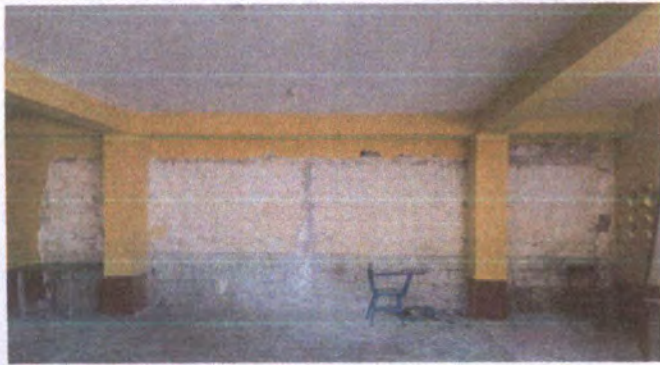
FOTO 7: Remozamiento de repello en muro
