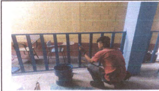
FOTO 2: Mantenimiento a barandas de metal en pasillos
