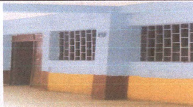
FOTO 9: Aplicación de pintura en muros
