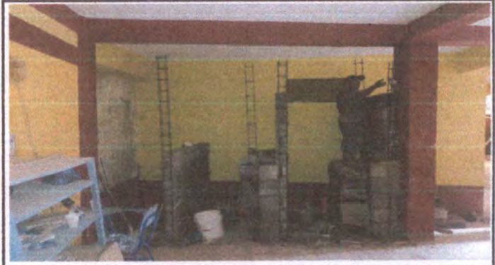
FOTO 8: Levantado de muro para area de baño
