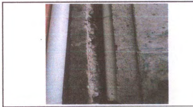
FOTO 6: Reparación de tubería de drenaje pluvial
