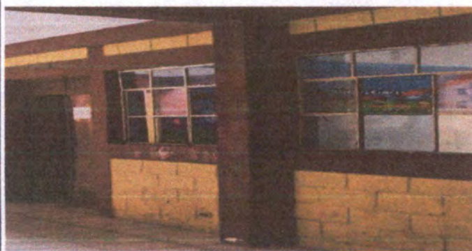
FOTO 9: Aplicación de pintura en muros
