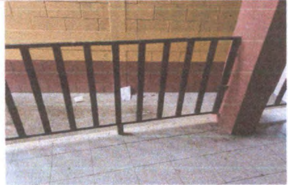
FOTO 2: Mantenimiento a barandas de metal en pasillos
