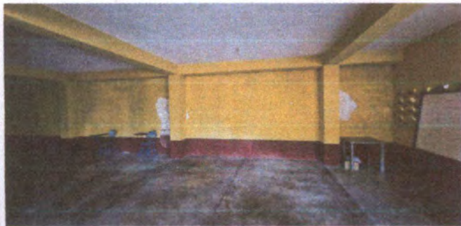
FOTO 7: Remozamiento de repello en muro
