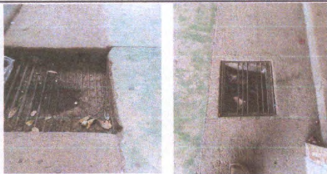
FOTO 5: Reparaciones en cajas de drenaje pluvial
