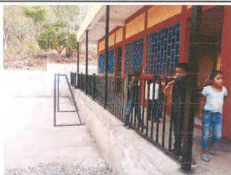
trabajo de barandas en pasillo frente a aulas de primaria finalizado
