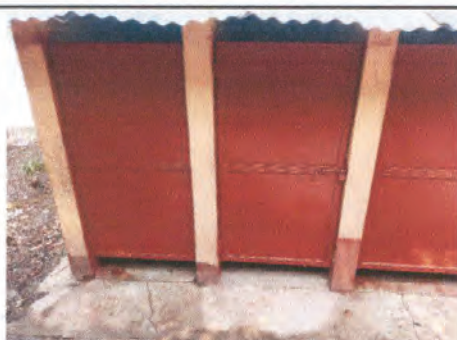
trabajo de mantenimiento a puertas de sanitarios finalizado
