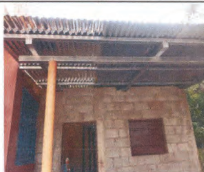
trabajo de mejoramiento de techo de cocina finalizado
