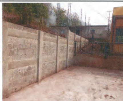
Trabajo de sección de muro perimetral de contención finalizado
