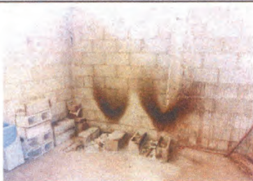
Área de cocina a mejorar
