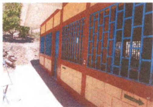
Área de ventanas que se mejorará
