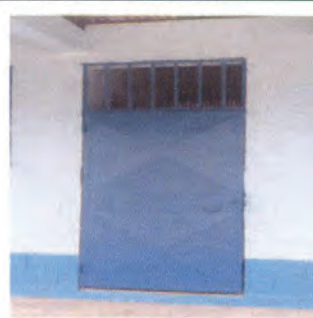
Foto 6: REPARACIÓN, PINTADO Y CAMBIO DE CHAPA DE PUERTA
