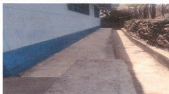
Foto 4: ELABORACIÓN DE CUNETA DE AGUA FLUVIAL
