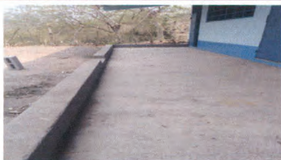
Foto 5: COLOCACIÓN DE BORDILLO
