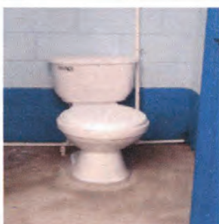
Foto 3: SUSTITUCIÓN DE BAÑOS
