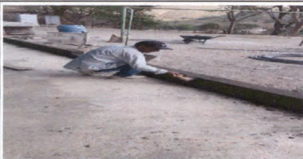
Foto 5: COLOCACIÓN DE BORDILLO
