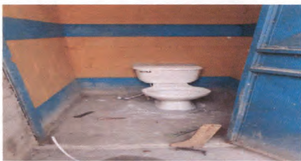
Foto 3: SUSTITUCIÓN DE BAÑOS
