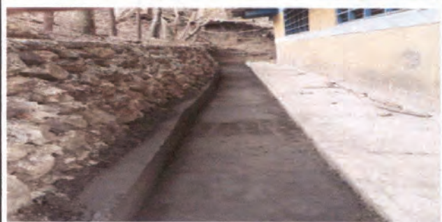
Foto 4: ELABORACIÓN DE CUNETA DE AGUA FLUVIAL
