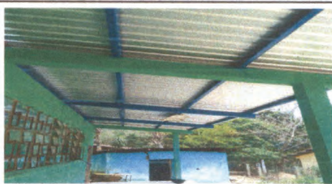
Foto: Techo del edificio escolar
