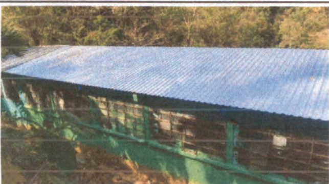
Foto 3: finalización del techo del edificio escolar
