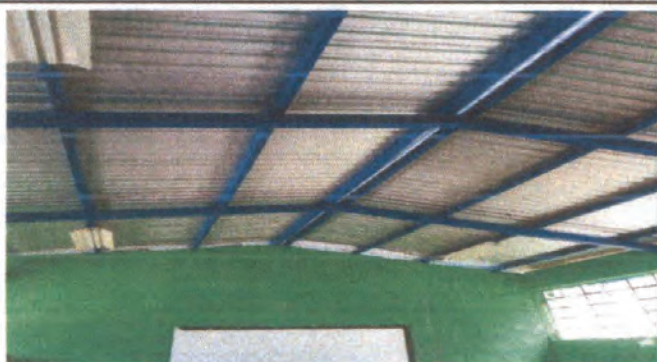
Foto 1: Reparación de costaneras
