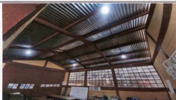
FOTO 1: Sustitución de lámparas
