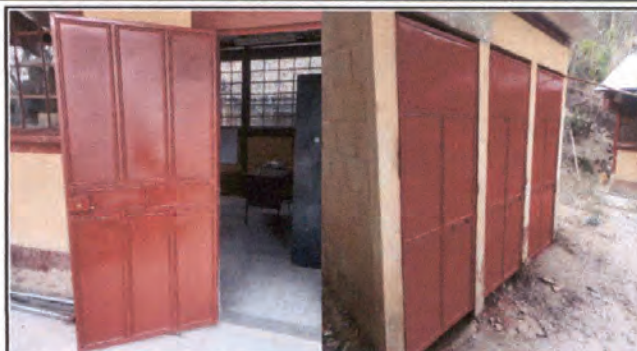
FOTO 2: Mantenimiento a estructura de puertas (lijado, cambio de tubo, cepillado, sujecciones, aplicación de pintura)
