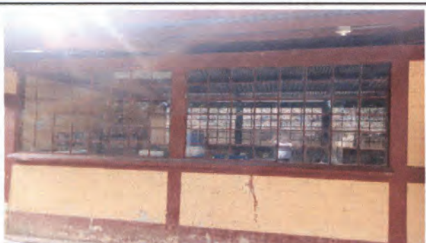
FOTO 3: Mantenimiento de ventanas
