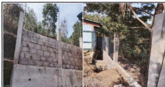
FOTO 5: Construcción de muro perimetral
