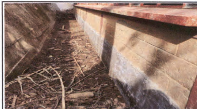
FOTO 4: Alisado de cemento para zócalo.
