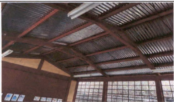
FOTO 1: Sustitución de lámparas
