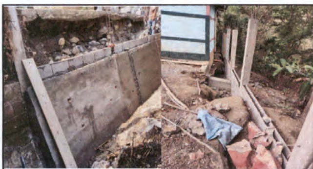
FOTO 5: Construcción de muro perimetral
