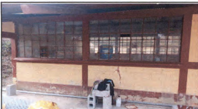
FOTO 3: Mantenimiento de ventanas
