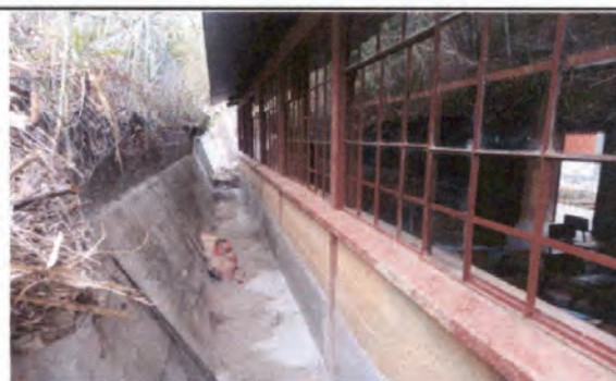
FOTO 4: Alizado de cemento para zócalo
