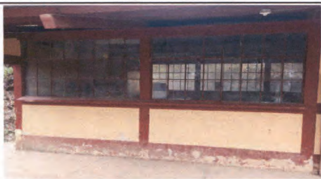
FOTO 3: Mantenimiento de ventanas
