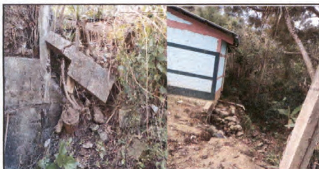
FOTO 5: Construcción de muro perimetral
