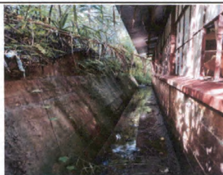
FOTO 4: Alisado de cemento para zócalo.
