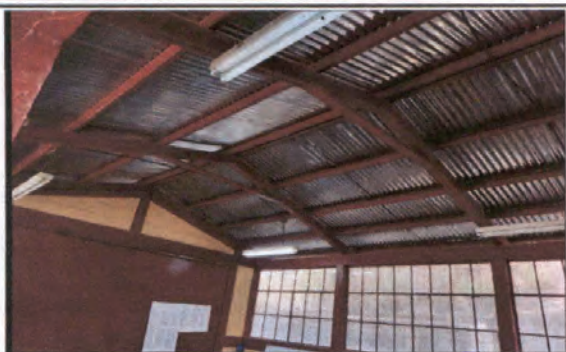
FOTO 1: Sustitución de lámparas
