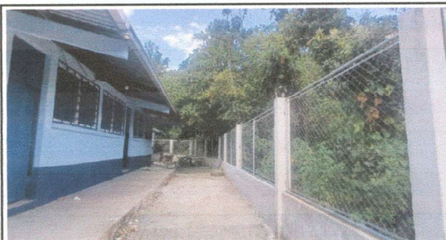
Foto 6: Pintura en muros exteriores e interiores
