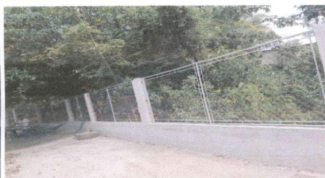
Foto 3: Reparación de muro perimetral
