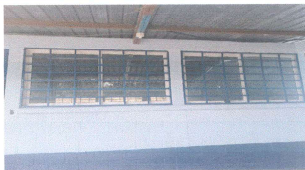
Foto 4: Sustitución de ventanales
