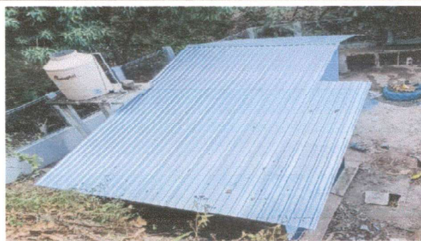
Foto 2: Sustitución de lámina troquelada aluzinc
