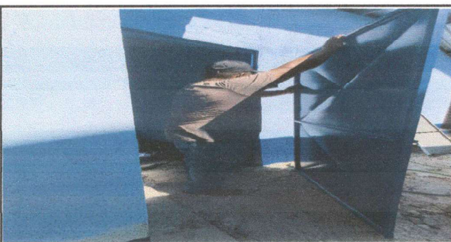
Foto 5: Sustitución e instalación de puerta de metal
