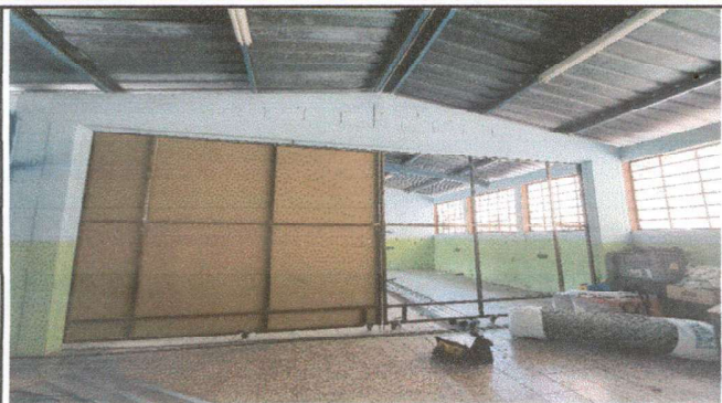
Foto 1: Sustitución de tablayeso en aula
