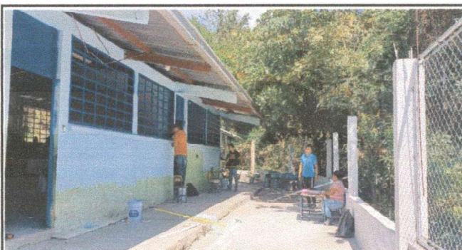
Foto 6: Pintura en muros exteriores e interiores
