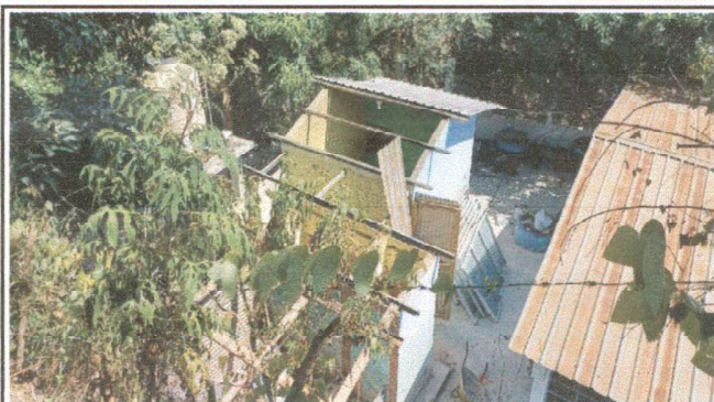
Foto 2: Sustitución de lámina troquelada aluzinc
