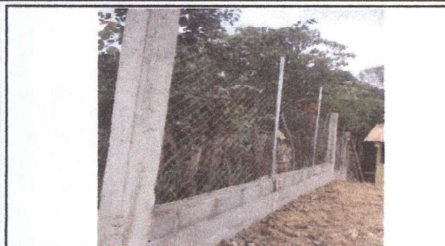
Sustitución de malla
