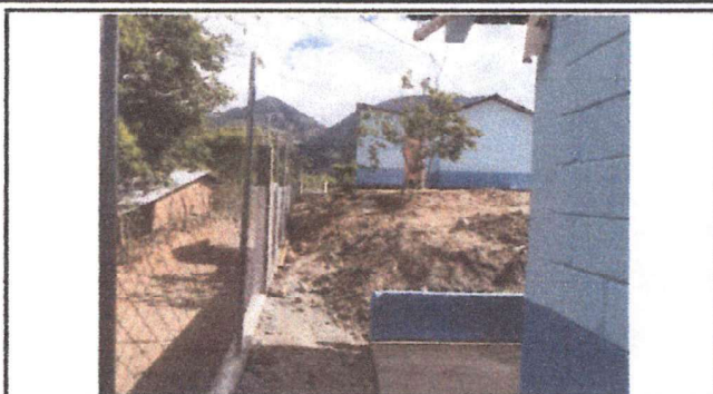
Sustitución de malla
