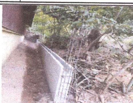
Sustitucion de malla perimetral
