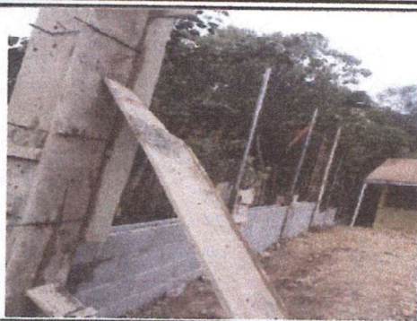
Sustitucion de malla perimetral
