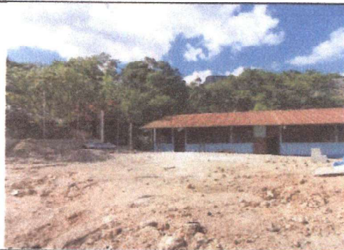
Sustitución de pintura, baños y cocina
