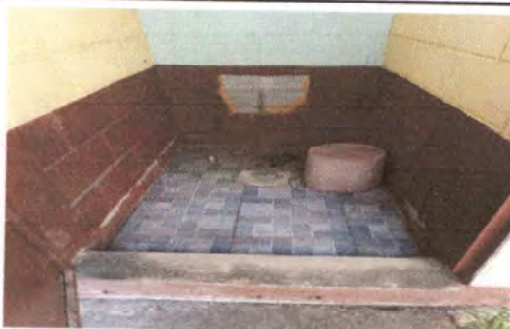
Sustitución de tubería de drenaje
