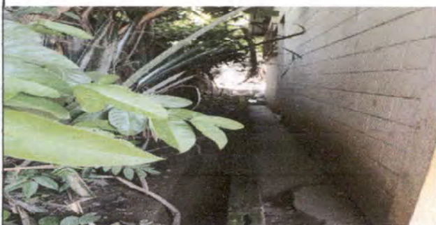
Sustitucion de malla perimetral
