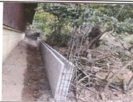
Sustitución de malla perimetral
