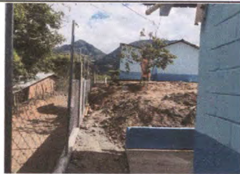
Sustitución de malla
