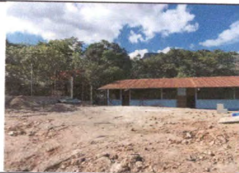
Sustitución de pintura, baños y cocina
