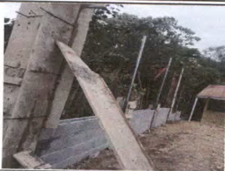
Sustitución de malla perimetral
