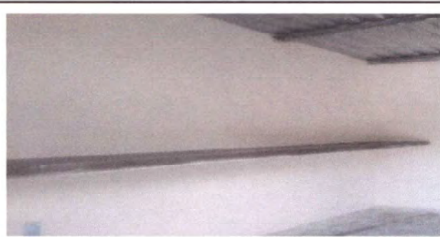
Foto 12: ELABORACIÓN DE PLANCHA DE CEMENTO EN COCINA
