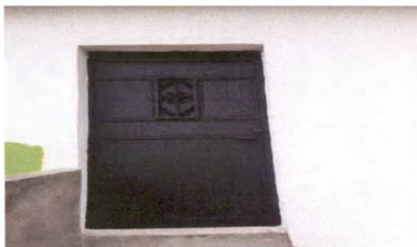
Foto 3: FABRICACIÓN E INSTALACIÓN DE PUERTA DE METAL
