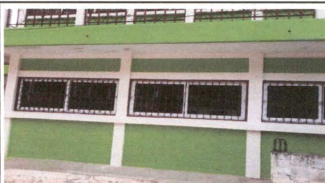
Foto 10: SUSTITUCIÓN DE VENTANAS CON VIDRIOS POR VENTANAS DE PVC CORREDIZAS
