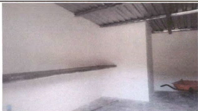
Foto 9: CERNIDO EN PAREDES
