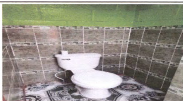
Foto 6: SUSTITUCIÓN DE INODOROS PORQUE SE ENCUENTRAN EN MAL ESTADO.
