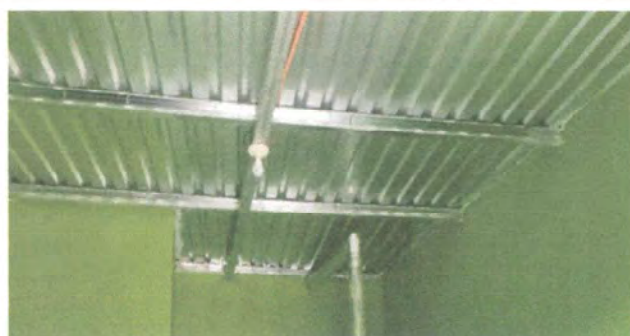
Foto 2: SUSTITUCIÓN DE ESTRUCTURA DE MADERA POR METAL
