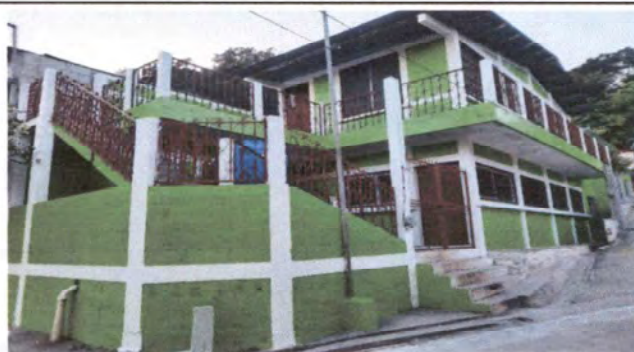
Foto 4: PINTURA EN MUROS EXTERIORES E INTERIORES
