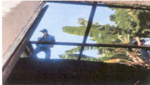
Foto 2: SUSTITUCIÓN DE ESTRUCTURA DE MADERA POR METAL
