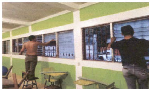
Foto 10: SUSTITUCIÓN DE VENTANAS CON VIDRIOS POR VENTANAS DE PVC CORREDIZAS.
