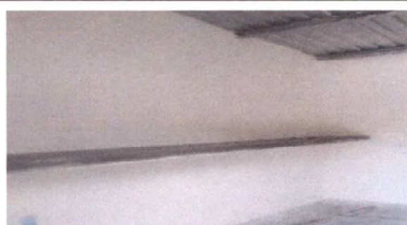
Foto 12: ELABORACIÓN DE PLANCHA DE CEMENTO EN COCINA
