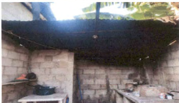
Foto 1: SUSTITUCIÓN DE LÁMINA POR LÁMINA TROQUELADA
