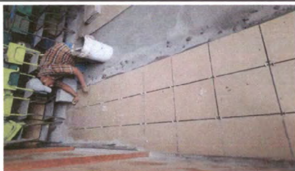
Foto 5: SUSTITUCIÓN DE PISO CERÁMICO, PORQUE SE ENCUENTRA LEVANTADO Y QUERADO DEL CONCRETO
