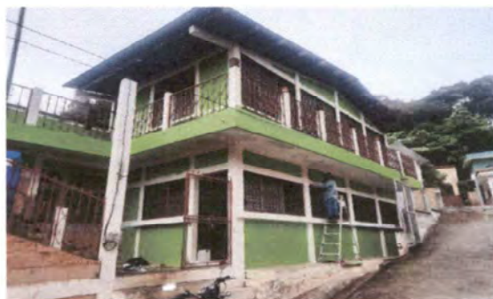
Foto 4: PINTURA EN MUROS EXTERIORES E INTERIORES
