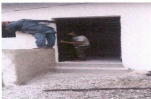
Foto 3: FABRICACIÓN E INSTALACIÓN DE PUERTA DE METAL
