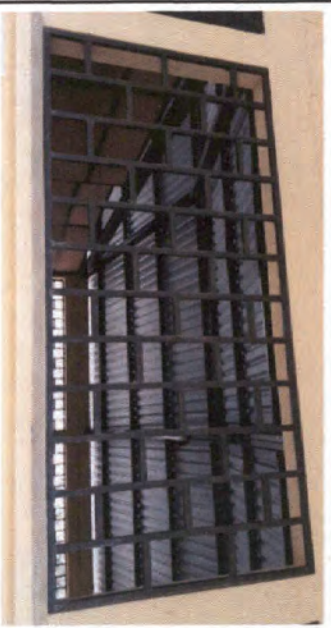
Foto 4: Reforzamiento de balcones
