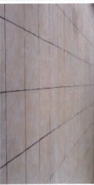
Foto 6: Reparación de piso
