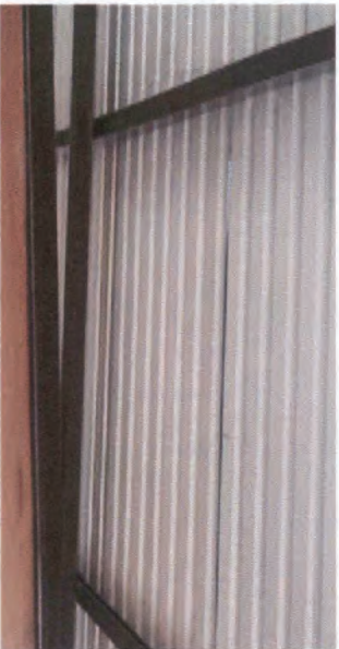
Foto 5: Reparación de techo
