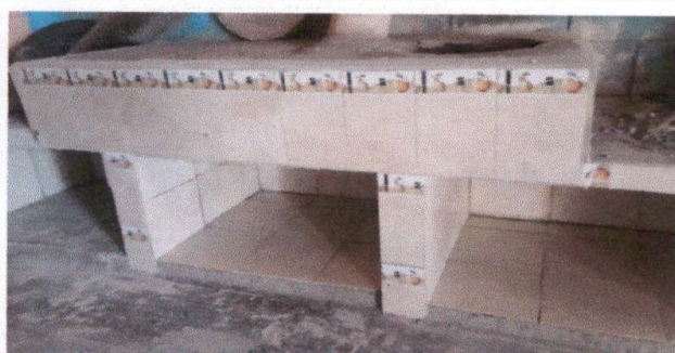
Foto 3: Reparación de poyetón y Pintura
