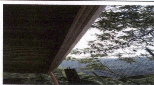
Foto 2: Reparación de Canales
