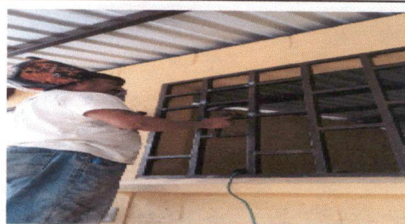
Foto 4: Reforzamiento de balcones
