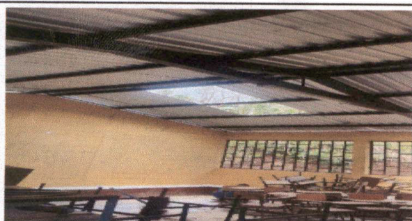
Foto 5: Reparación de techo
