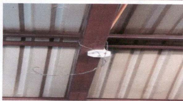
Foto 1: Instalación de energía eléctrica.
