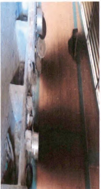
Foto 3: Reparación de poyotón y Pintura
