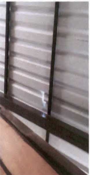
Foto 5: Reparación de techo
