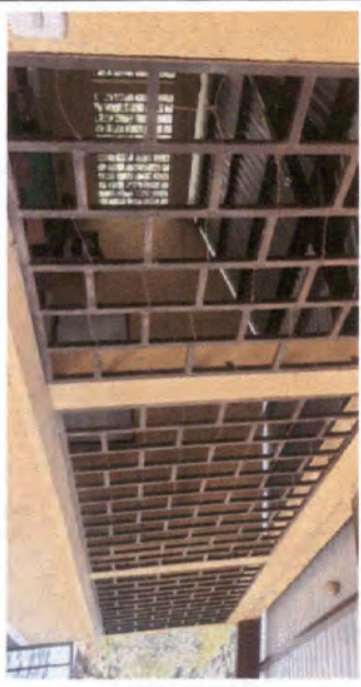
Foto 4: Reforzamiento de balcones
