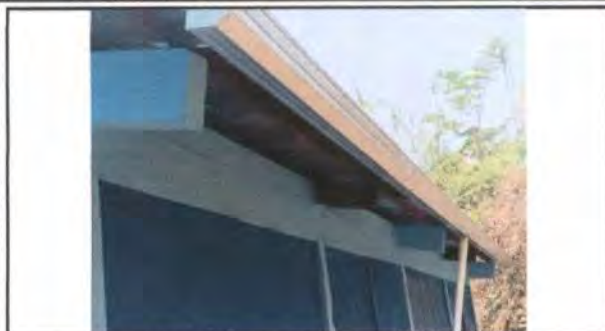
Foto 7: Instalación de canales completado
