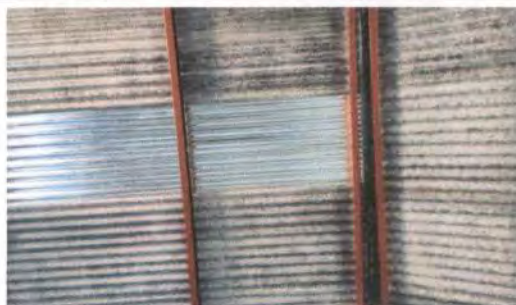
Foto1: Sustrucción de Láminas (solo las láminas dañadas o agujereadas) culminado
