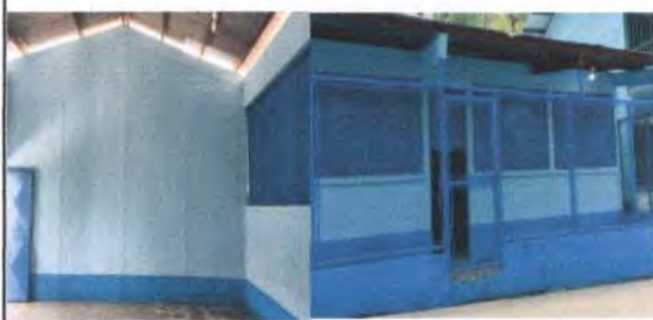
Foto 3: Pintura en muro exterior e interior culminado
