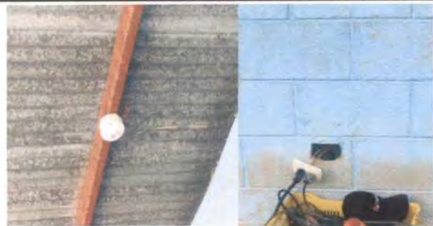
Foto 5: Sustitución de lámparas por plafoneras, tomacorriente y cableado eléctrico completado
