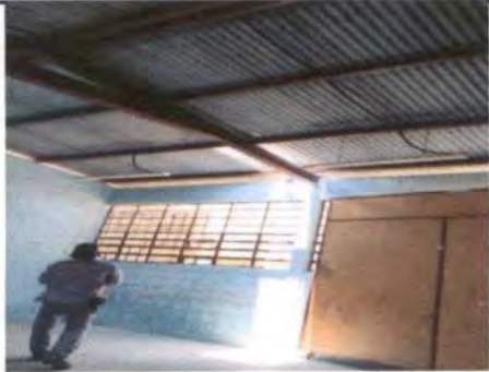
Foto 1: Sustitución de Láminas completado
