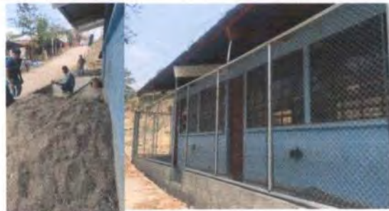
Foto 4: Muro Perimetral y reparación de pasillo completado
